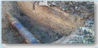
1- Excavation de la conduite
