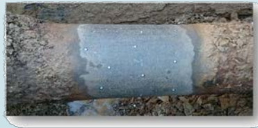
2- Préparation de surface
