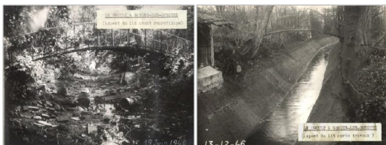
Le Croult à Garges-lès-Gonesse, avant et après reprofilage en 1946
