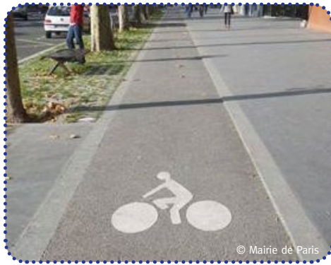
Avenue de la Porte d'Ivry (13 e ) : le revêtement de la piste cyclable laisse la pluie s'infiltrer dans le sol, les pavés entre les arbres aussi, tout en accueillant de l'herbe.
