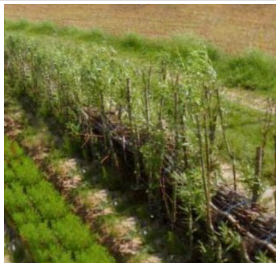
Une fascine, barrière végétale, permet de lutter contre l'érosion
