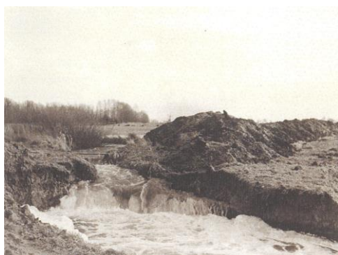
Le Huillard après travaux d'élargissement
