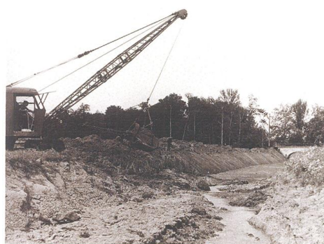
Travaux d'élargissement sur la Bezonde
