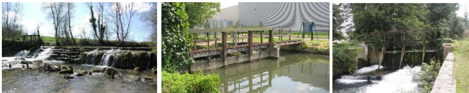
Photo 5, 6 et 7 : Seuil de Varennes sur la Blaise (Haute-Marne), vannages du Reveillon et de Fortisle sur la Blaise (Eure-et-Loir) (© Agence de l'Eau Seine Normandie, Onema, Fédération de pêche de l'Eure-et-Loir).
