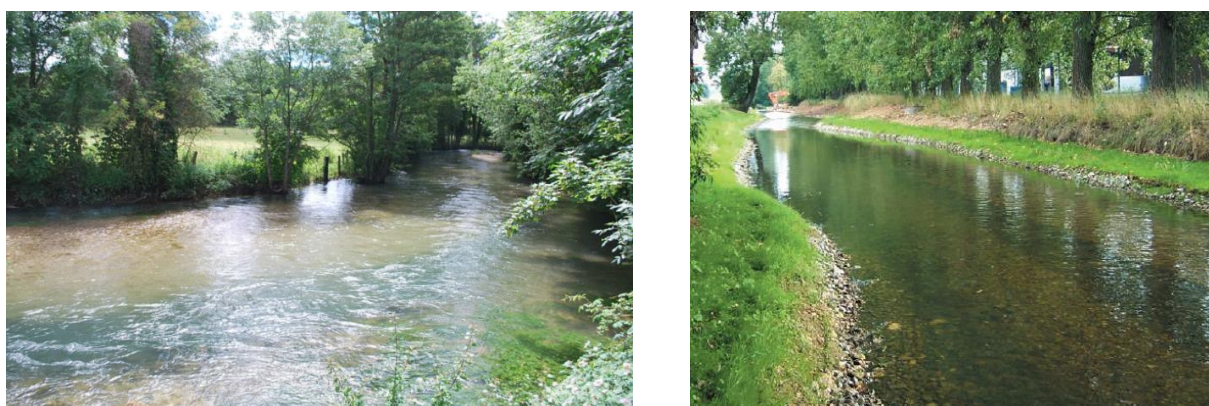
Photos 8, 9 : Vues de la Blaise (Haute-Marne) en aval du seuil de Varennes et de la Blaise (Eure-et-Loir) en amont du seuil de Réveillon après les travaux (© Ecogea, Fédération de pêche de l'Eure-et-Loir).
