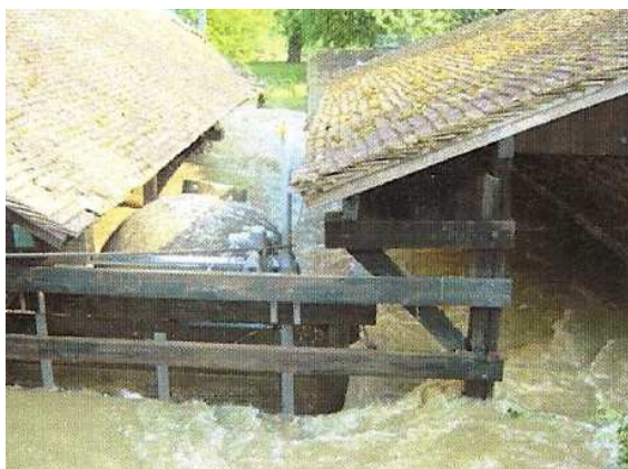
Débordement de la Mérantaise au niveau du lavoir de Gif-sur-Yvette le 29 avril 2007
